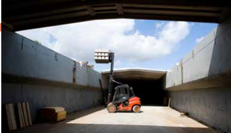
De heftrucks laden en lossen makkelijk 200 ton per uur.
